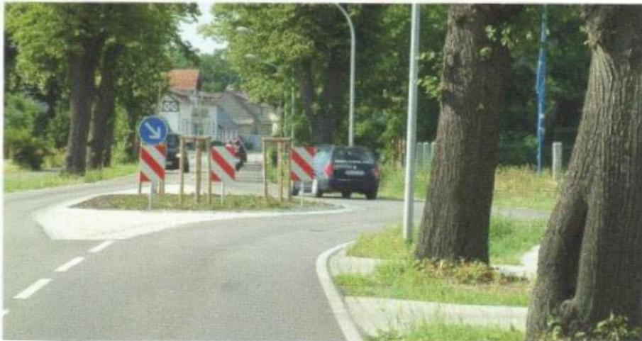
Abbildung: Beispiel einer Geschwindigkeitsdämpfung im Ortseinfahrtbereich durch Mittelinsel mit deutlichem Fahrbahnversatz; Quelle: RASSt06
