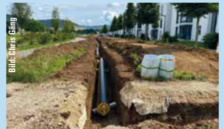
**Unsichtbar:** Die Fernwärme wird vom Heizwerk über isolierte Erdleitungen in die Wohn- und Gewerbehäuser transportiert.
