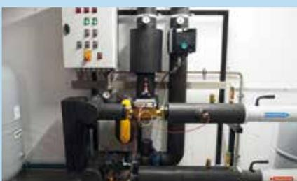
**Platzsparend:** Im Haus selbst sorgt eine kompakte Übergabestation für die Verteilung der Wärme. Die Kosten für Bau und Wartung einer Heizung entfallen. Im Falle einer Störung bietet die swt einen 24-Stunden-Bereitschaftsdienst.
