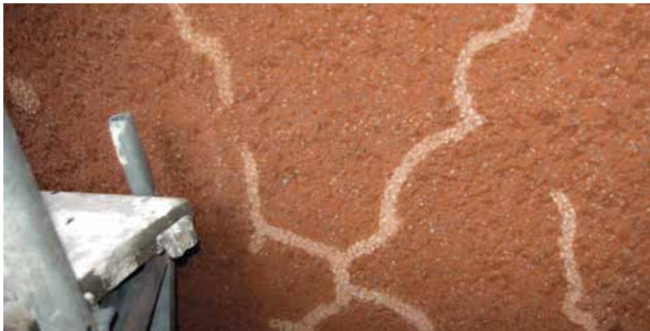
Vorarbeiten: Zum Sanieren gehörte auch, Risse im Putz zu festigen und aufzufüllen.
