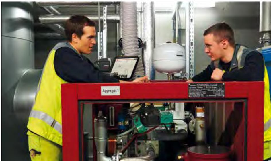
Simon Degen erklärt einem Auszubildenden den 6-Zylinder-Motor eines BHKWs, das klimafreundlich Wärme und Strom erzeugt.
