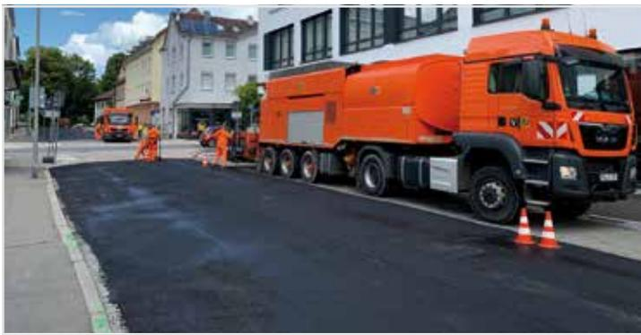
Nach einem Tag abgeschlossen: Sanierung der Karlstraße mit Dünnschichtasphalt
