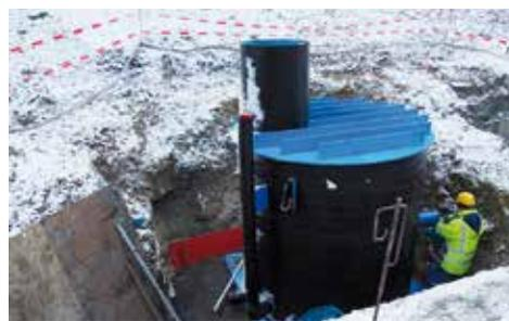
Einbau des neuen Quellsammelschachts
