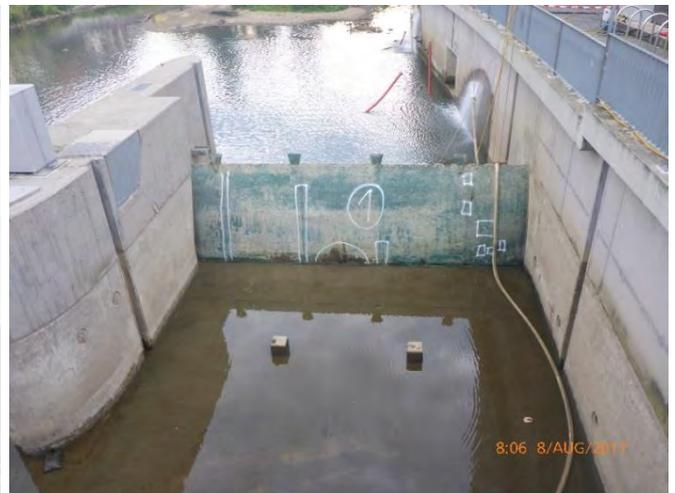
**Bild 6:** Ansicht Feld 4 unter Trockenlegung (links), Ansicht Feld 1 unter Trockenlegung (rechts)
