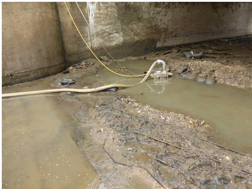
**Bild 25:** Objektbegehung im trockengelegten Wehrfeld, Spundwand stromaufwärts am Beginn des Einlaufbeckens sowie Pumpmaßnahmen des Technischen Hilfswerks (THW), 08.08.2017
